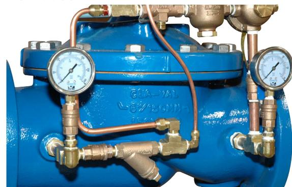
\*Especifique el rango de presión deseado y colocación del manómetro en la válvula (entrada o salida) en la orden de compra.
