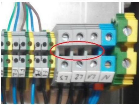
Figura 3.2: Conexión en línea trifásica
