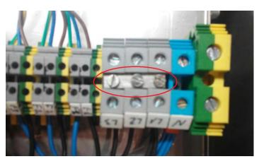
Figura 3.1: Conexión en línea monofásica
